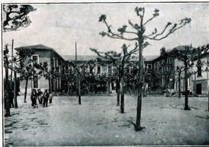
Vista exterior del Asilo
