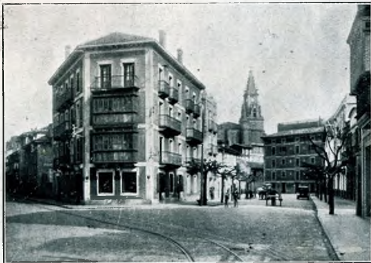
Confluencia de la calle de los Fueros y de Viteri. Al fondo, la iglesia de la villa, parroquia de Santa María.
