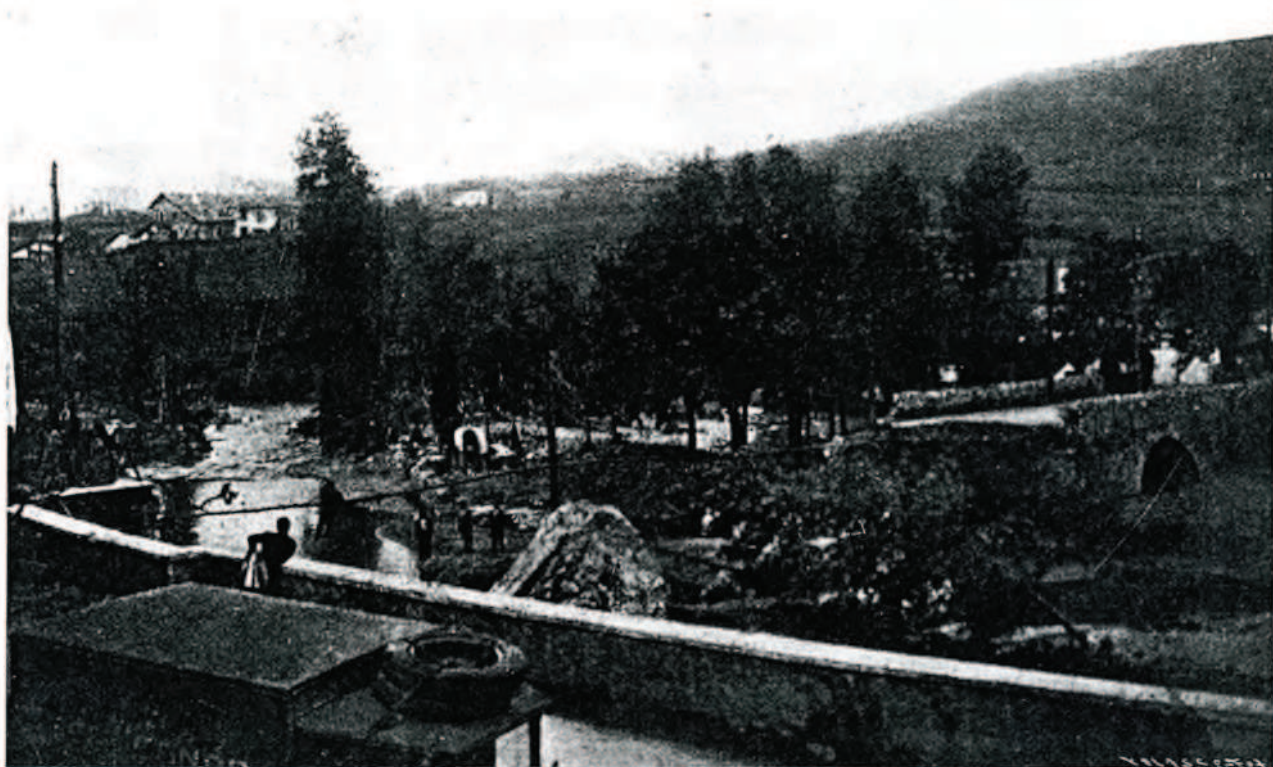
En el barrio oyarzuarra de Ugaldecho, quedó destruído el puente de la carretera de las Ventas.
