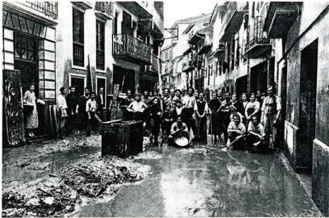
La calle de la Magdalena después de la inundación. Los vecinos, sonrientes—al mal tiempo buena cara—se disponen con palas y cubos, a reparar los destrozos causados por las enfurecidas aguas del Oyarzun.
