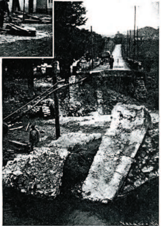
Detalle de los destrozos causados por las aguas en el puente de la carretera de las Ventas a Oyarzun, en «Ugaldecho».
