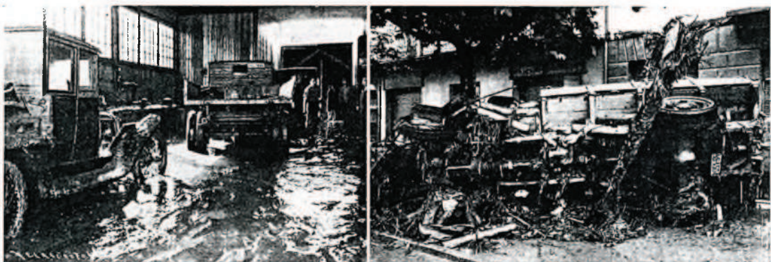
Interior de la Esmaltería Guipuzcoana y camión derribado por las aguas en la calle de Viteri. (De izquierda a derecha.)
