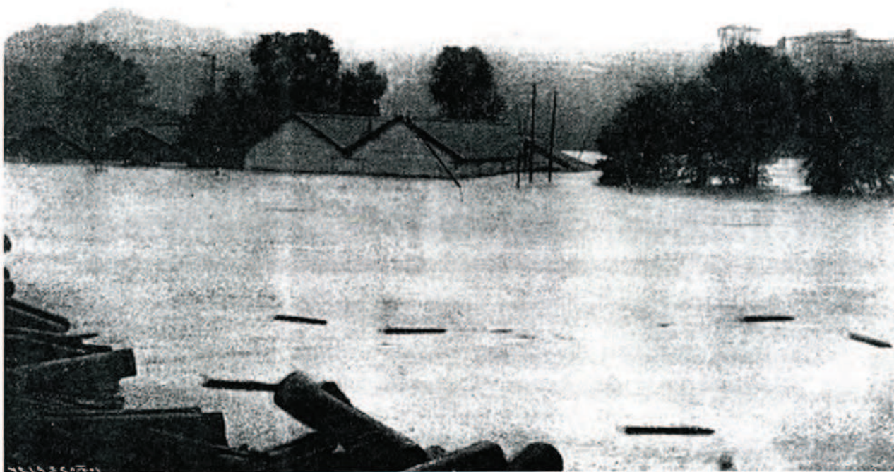
Desolador aspecto que presentaba la carretera de Irún, en Gabiarrota. Las aguas desmandadas, amenazan con ocultar árboles, viviendas y pabellones de industria, saciando así su sed destructora.
