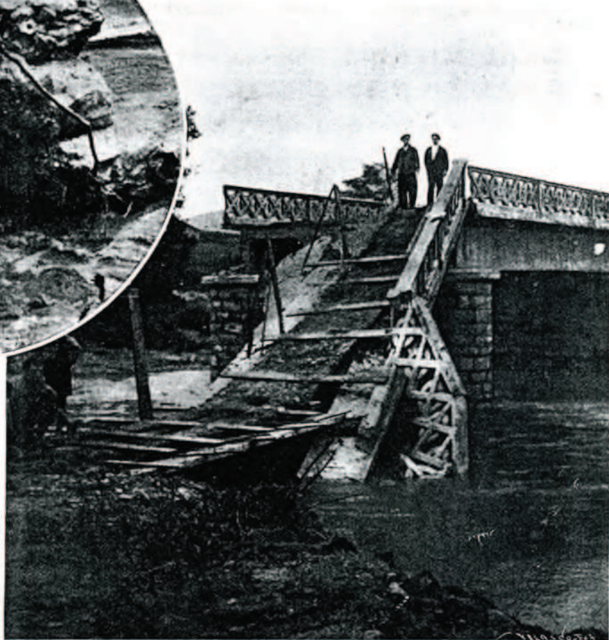
El puente de la carretera de Ugaldecho, maltratado por la corriente. Ved cómo quedó cuando bajaron las aguas.
