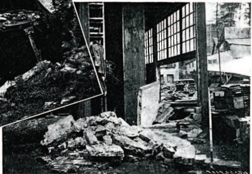
Uno de los pabellones de la Papelera Española, donde la inundación causó sensibles destrozos.
