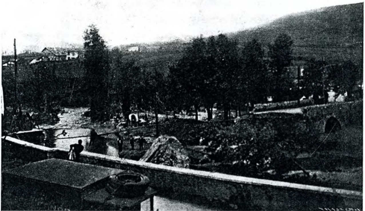
En el barrio oyarzuarra de Ugaldecho, quedó destruído el puente de la carretera de las Ventas.
