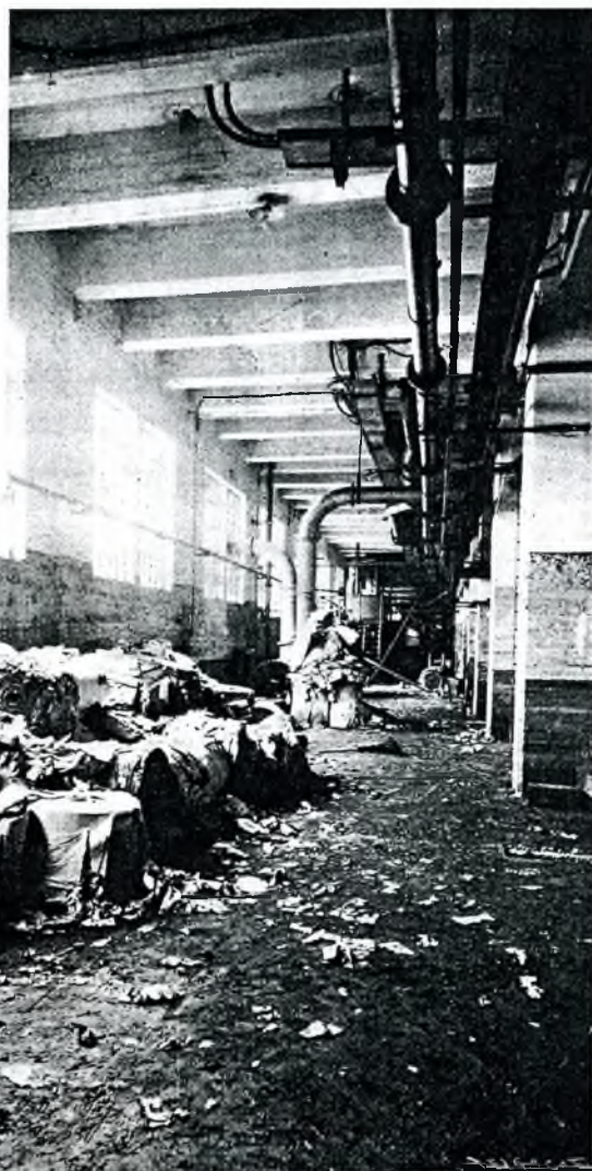
Un detalle de la Papelera Oarso, después de la riada, en el que se pueden apreciar considerables destrozos.
