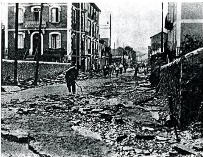
La carretera de Irún, en el punto denominado «Gabiarrota», donde las aguas levantaron el firme.
