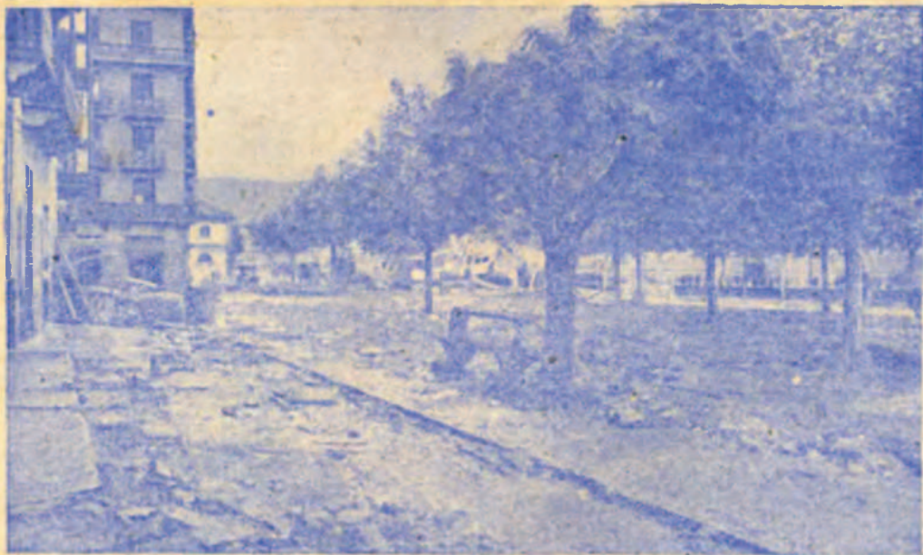
La Alameda, arrasada, ofreció este lamentable aspecto cuando las aguas se retiraron.....
