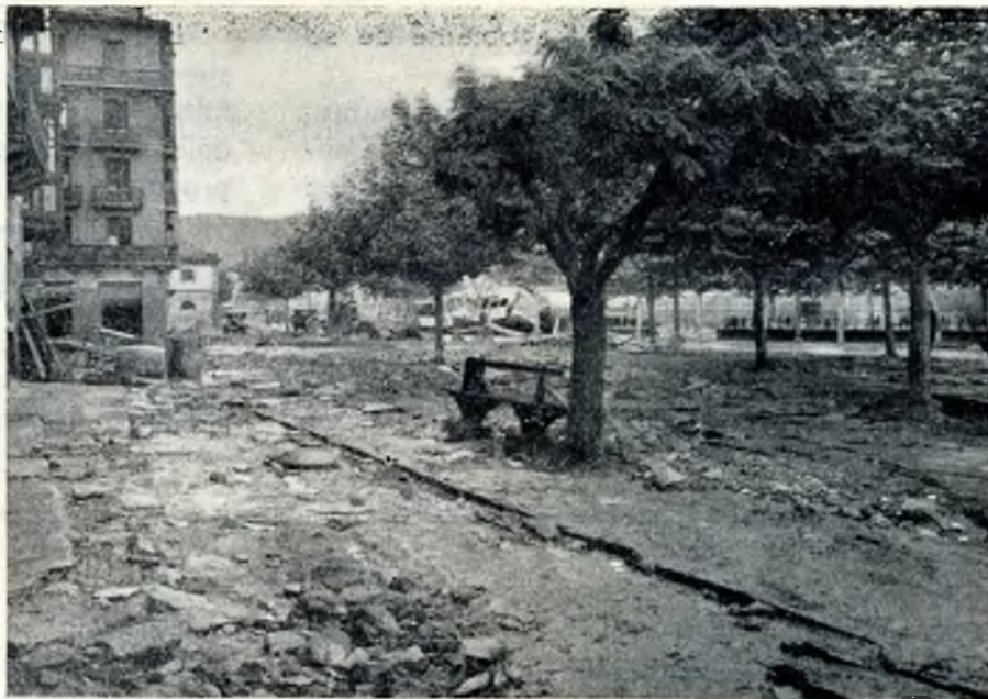
Aspecto desolador que, apenas bajaron las aguas, ofrecía la Alameda renteriana, en Octubre de 1933. (Foto Schneidhofer.)
