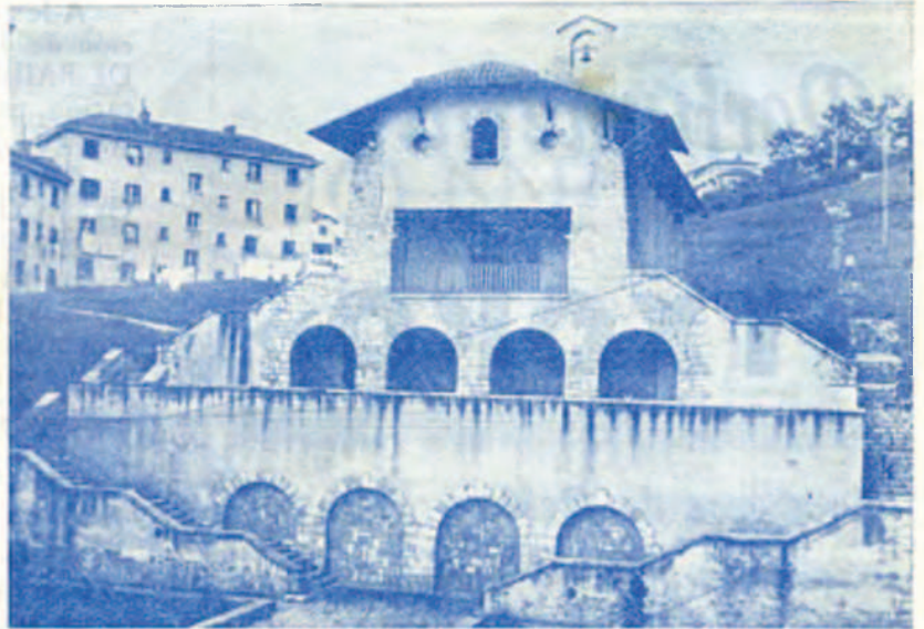
Capilla del poblado de Alaberga, cuya solemne inauguración tendrá lugar, seguramente, en otoño próximo. - (Foto, Zaragoza - Rentería)
