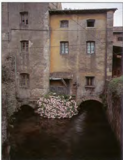
La Fandería, antigua ferrería municipal que pasó a manos privadas en 1769, transformándose entonces en fundición. Destruída en la última carlistada, siguió aprovechando sus instalaciones hidráulicas como molino harinero hasta pasado el medio siglo actual.
