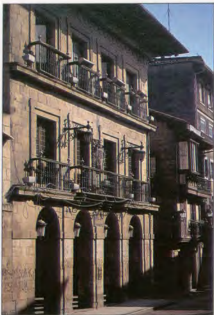
Ayuntamiento de Rentería, erigido en el siglo XVII en los terrenos ganados por el casco medieval tras el ensanche del siglo XV. Este tipo de edificios, además de poseer una funcionalidad propia, representaban la fuerza del poder civil frente a otros estamentos.
