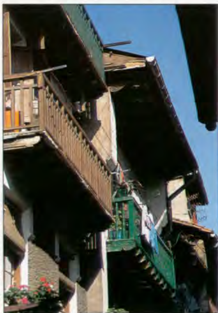
Viviendas de la calle del Medio. Algunos edificios todavía mantienen elementos tipológicos medievales, como las plantas sucesivamente voladas, esquinales saledizos, etc...
