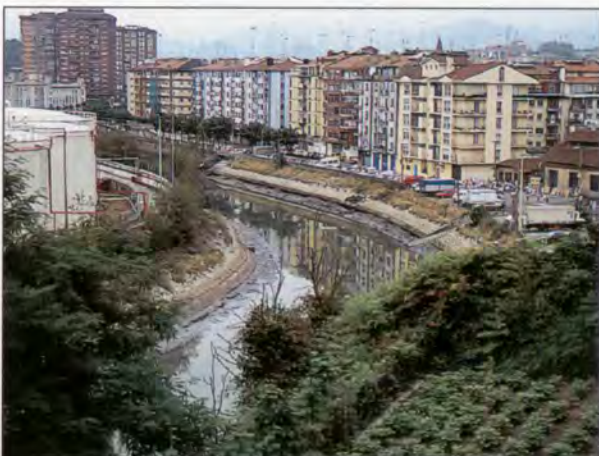
El río Oiartzun, actualmente encauzado, era una pequeña corriente fluvial en bajamar. No obstante, con marea alta, el cauce del Oiartzun y el canal de Rentería se inundaban, permitiendo el tránsito de embarcaciones de hasta 800 toneladas. También se anegaban las amplias marismas, hoy totalmente urbanizadas, que rodeaban parte del casco medieval contribuyendo a su defensa.
