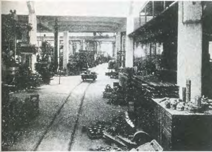
Vista parcial interior de los talleres.
