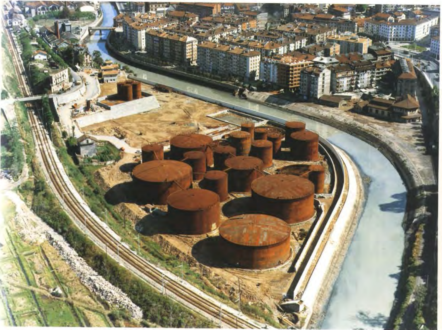
La construcción de los depósitos de CAMPSA en Iztietia en el año 1967.
