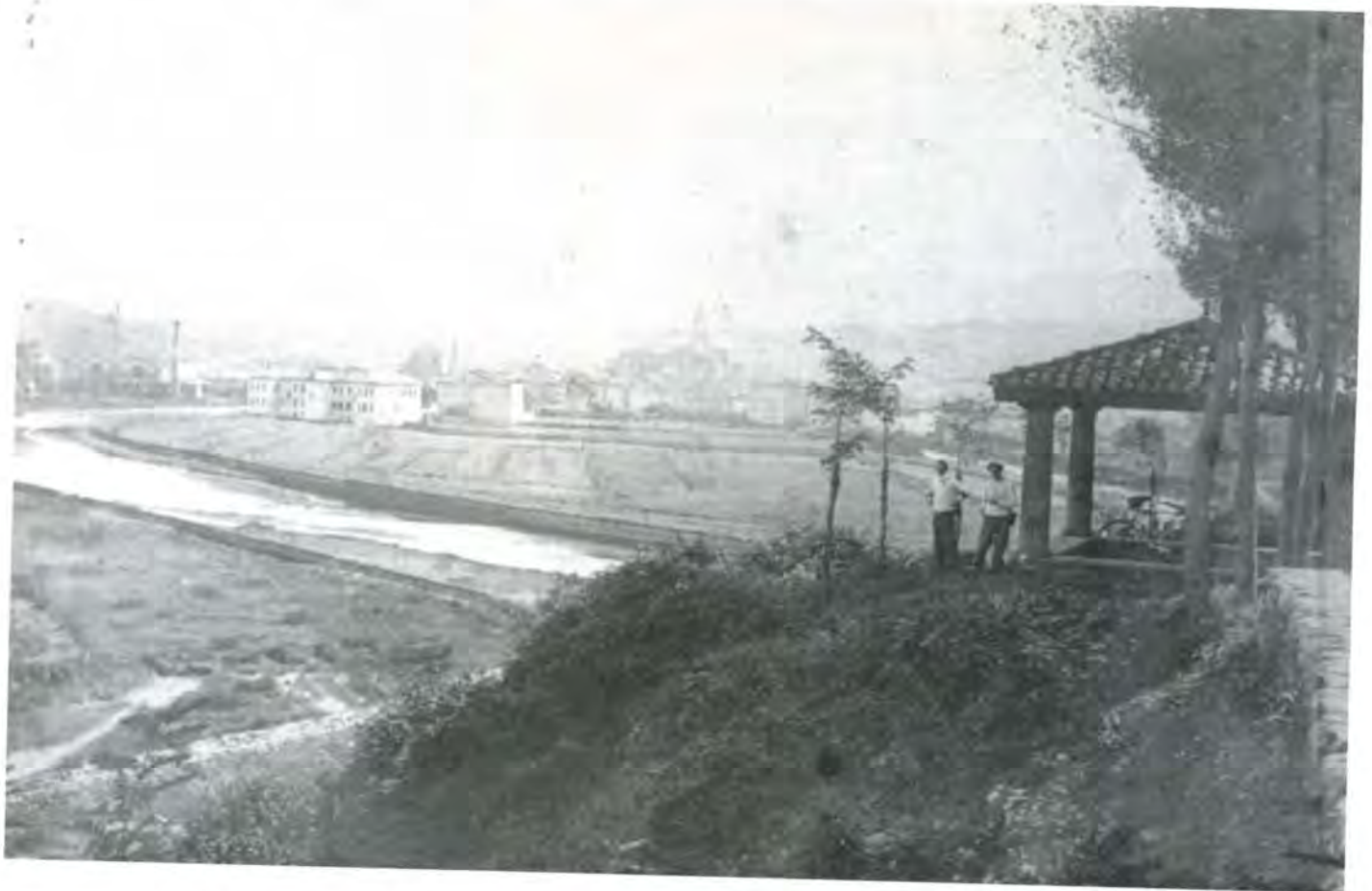
Vista general de Rentería desde el alto de Capuchinos. Al fondo las marismas de Iztieta y más a la izquierda las chimeneas de la fábrica de galletas "Olibet".
