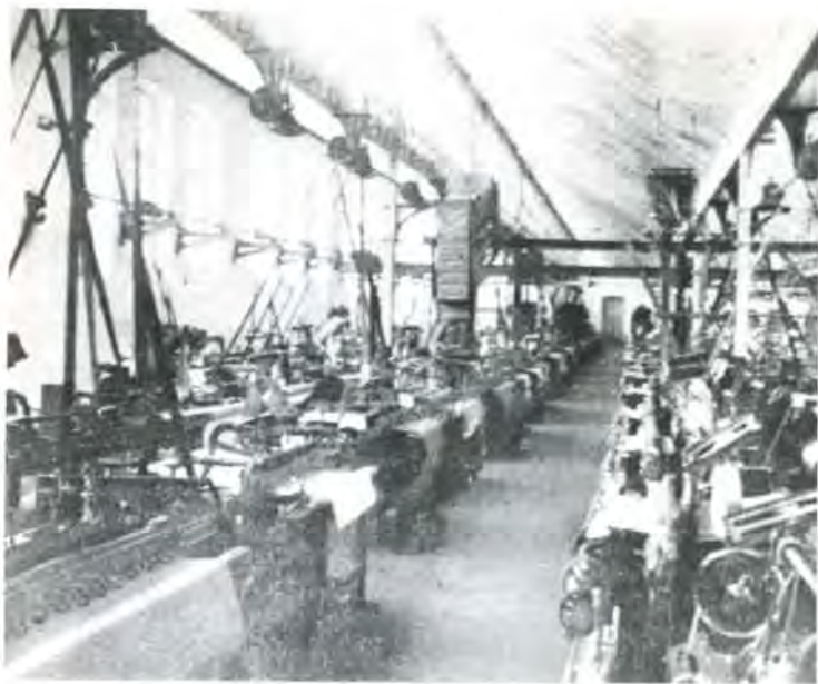
Nave de telares mecánicos de la Sociedad de Tejidos de Lino.
