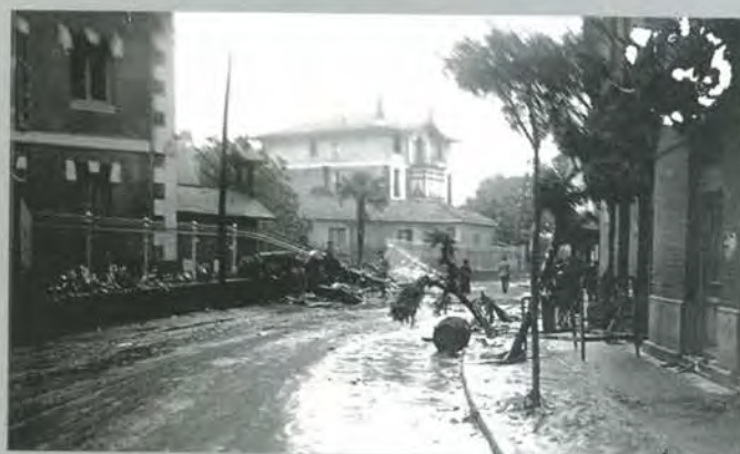
Avda. Mártires de la Libertad (antigua Avda. de la Estación-Renfe) Foto KUTXA
