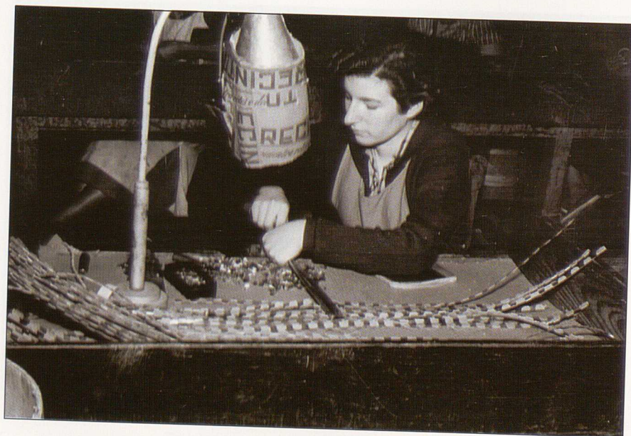
Jone Odriozola muntaia lanetan. Jone Odriozola en labores de montaje.
