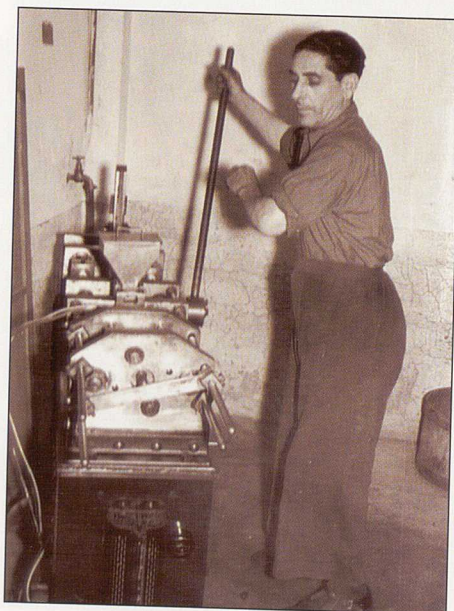
Kontaktuak 601 erregeletan sartzen. Introduciendo los contactos en las regletas 601.
