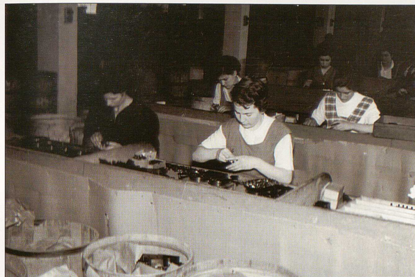
Muntatze lanetako langileak. Operarias de Montaje.
