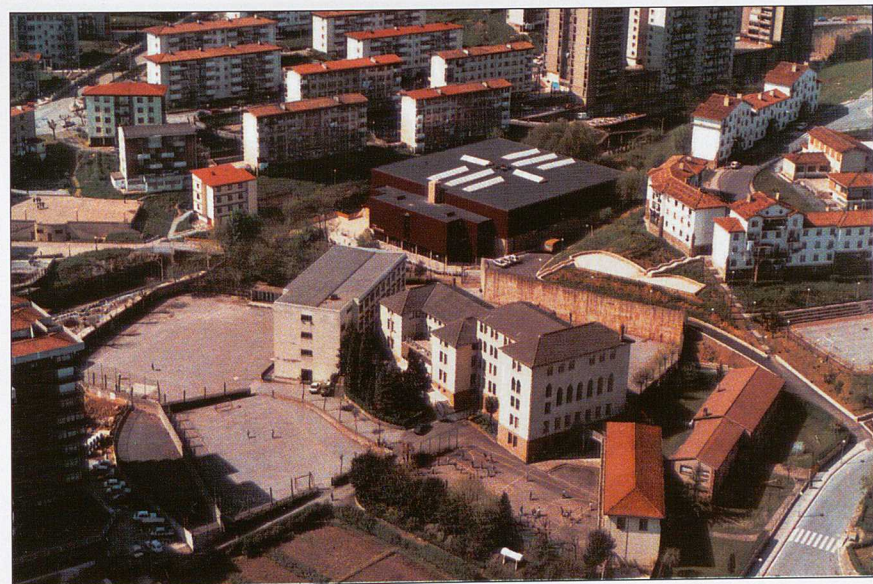
Telleri ikastetxearen etxe berria. Nuevo edificio del colegio Telleri
