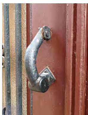
Errenteria. Orereta kalea, 1
